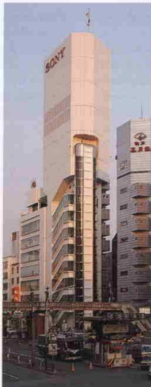
SONY TOWER, OSAKA, 1976 Um precursor do Centro Pompidou e do Lloyd's Building, de Rogers, a Sony Tower, de Kurokawa, tem os elementos de serviço — o elevador e as cápsulas do banheiro, revestidas de aço — pendendo da estrutura principal.
