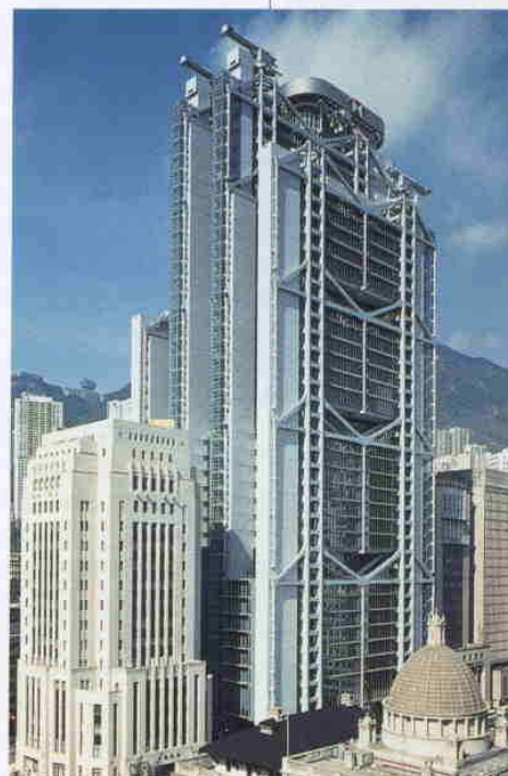
SEDE DO HONGKONG AND SHANGHAI BANK, 1979-1986
