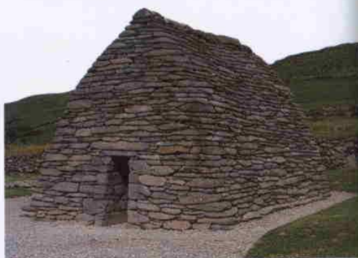
ORATÓRIO GALLARUS, DINGLE, IRLANDA, SÉCULO VIII Este mosteiro, perfeitamente preservado, em forma de barco tem uma única porta, pequena. A forma provavelmente deriva dos métodos de construção com pedra solta.
