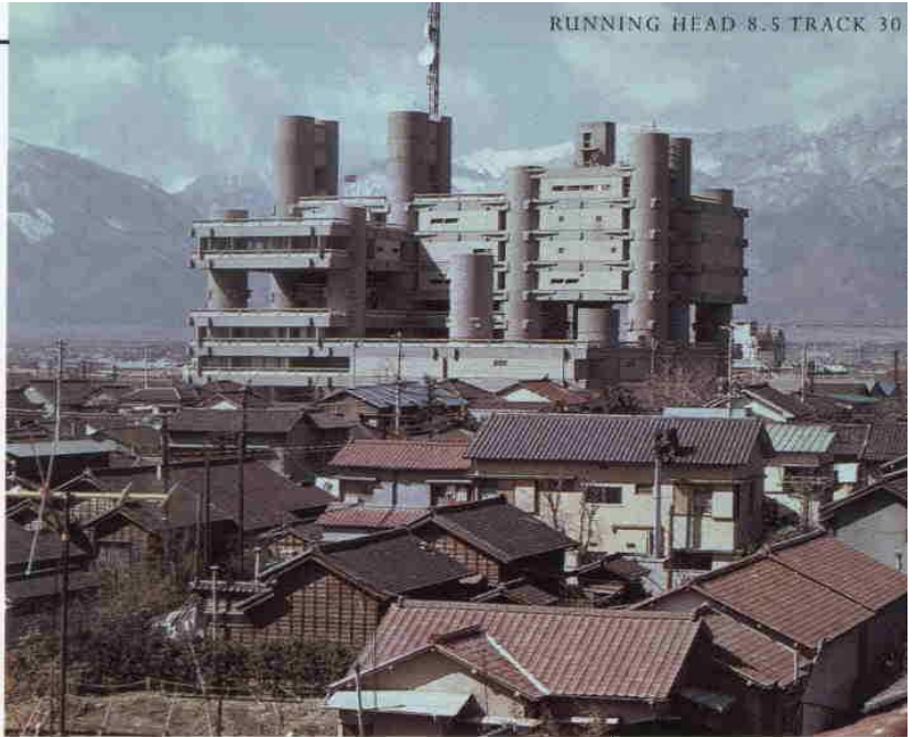
CENTRO DE COMUNICAÇÕES YAMANASHI, KOFU, 1964-1967 Dezesseis tubos ocos de concreto sustentam a enorme estrutura; neles ficam os serviços do centro. A natureza ampliável do edifício significa que, em certo sentido, ele continua inacabado.
