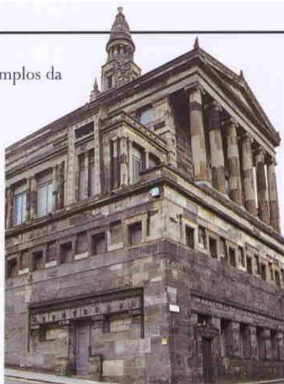
IGREJA DA ST. VINCENT STREET, GLASGOW, 1857-59 O projeto idiossincrático coloca a torre no canto do edifício. O uso confiante do idioma grego por Thomson foi um fator importante na grande resistência escocesa à revivescência gótica.
