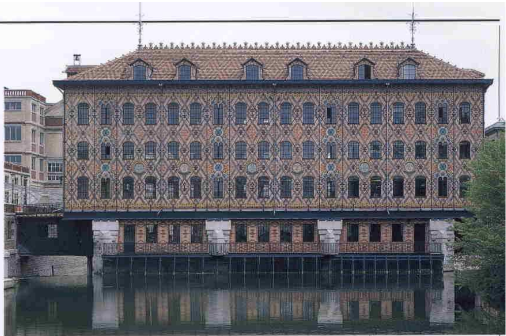
EDIFÍCIO DE TURBINAS, FÁBRICA MENIER, NOISIEL-SUR-MARNE, 1871-1872 O esqueleto de ferro do extraordinário edifício de Saulnier é uma estrutura auto-sustentável que permite grandes janelas e uma simples parede de tijolos, suspensa do lado de fora da estrutura de ferro.
