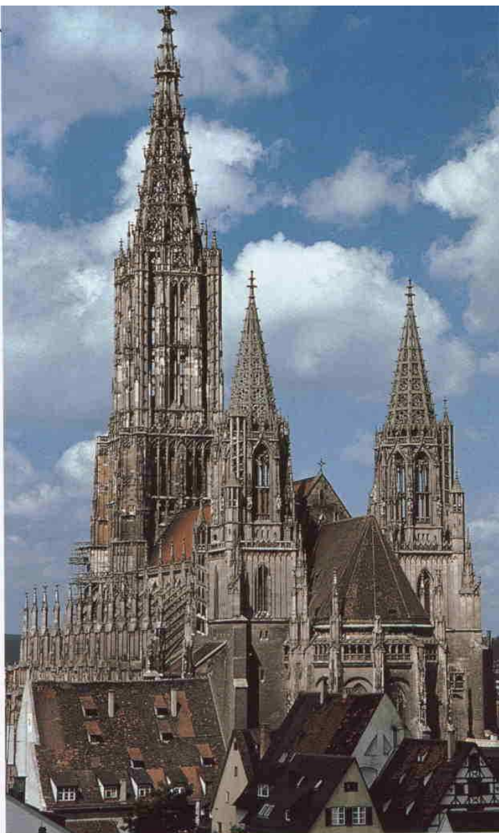
CATEDRAL DE ULM, SÉCULOS XIV-XVI, OCTÓGONO E AGULHA, SÉCULO XIX O octógono e a agulha da Catedral de Ulm só foram completados em 1890, quando o edifício se tornou a mais alta estrutura medieval da Europa, com uma altura de 160 m. A largura geral da nave é de 45 m.
