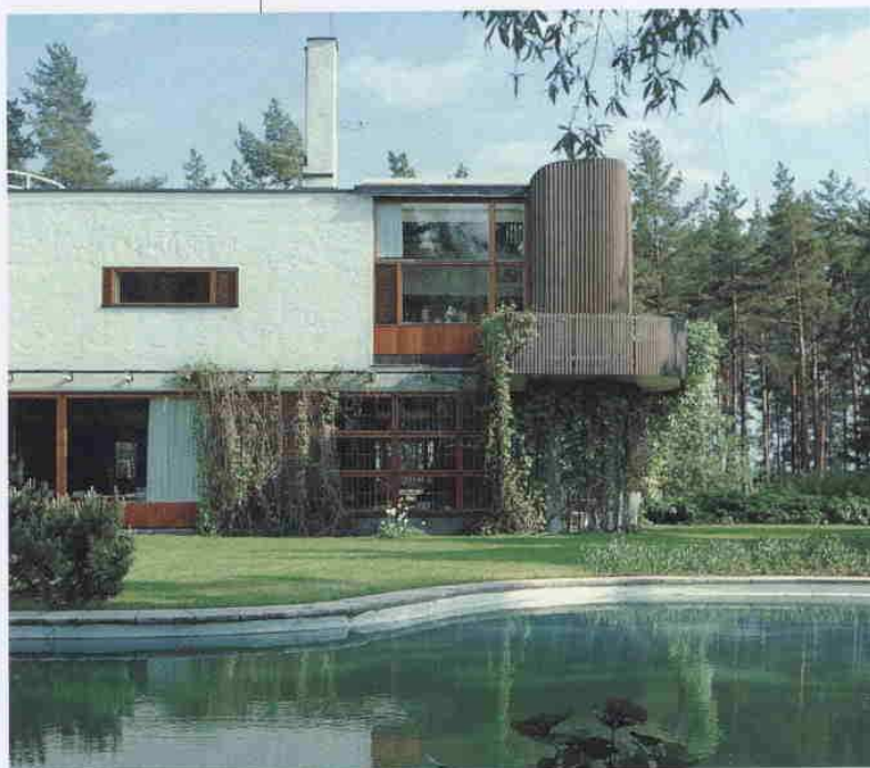
VILLA MAIREA, NOORMARKKI, FINLÂNDIA, 1938-1941
