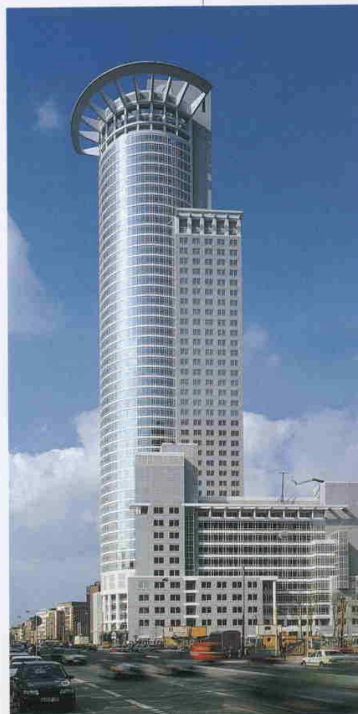
SEDE DO BANCO DG, FRANKFURT, 1993
