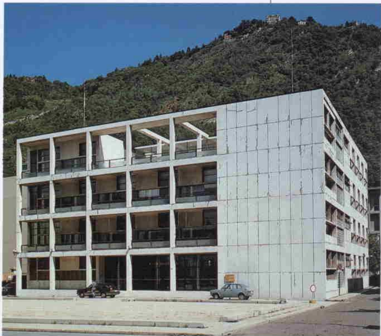
CASA DEL FASCIO, COMO, ITÁLIA, 1933-1936
